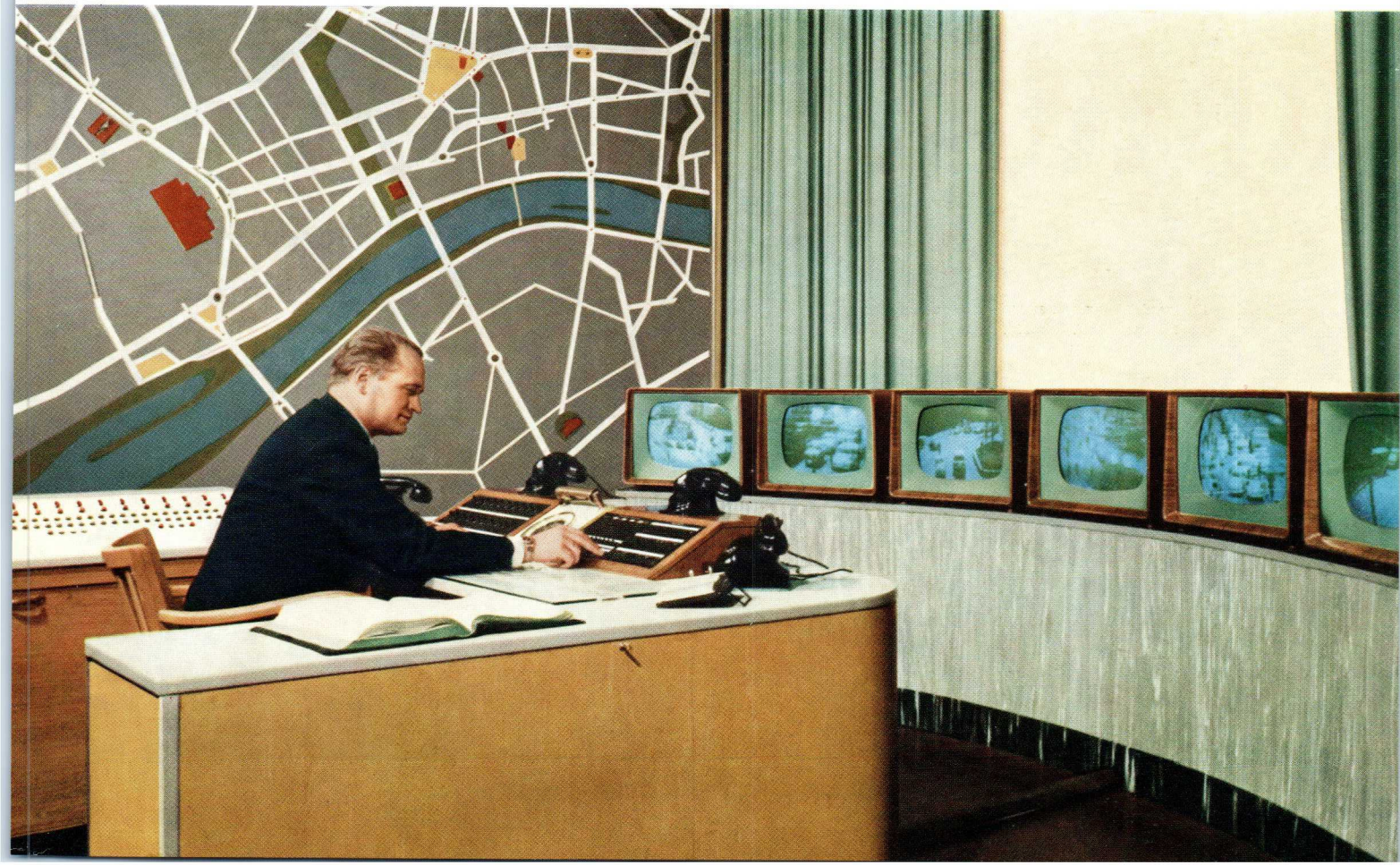
Zentrale Verkehrsregelung in der Großstadt mit Hilfe des Fernsehbildes
