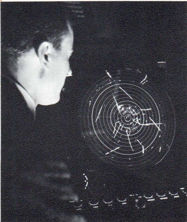
Observation sur écran de télévision d'une image PPI transformée par un tube à mémoire dont la longue rémanence permet de suivre la trace des avions.
